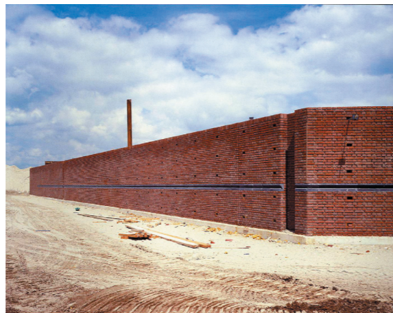
043 堤防建設途中のようす
