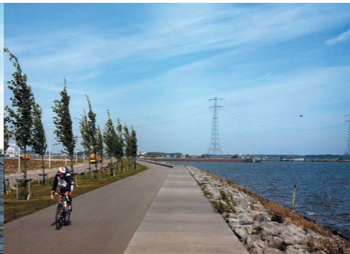
046 ザハテ・ウーファー側 に作られた石積み の堤防 047 レンガ造の堤防 048 堤防に沿って遊歩道が 作られている
