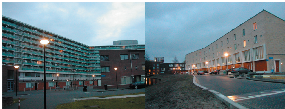
029 (左) ジグザグに折れ曲がった建物の形が特徴的な高層住棟
